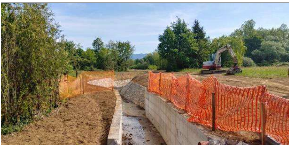
Fig. 10 Costruzione del canale in calcestruzzo a forma di U
