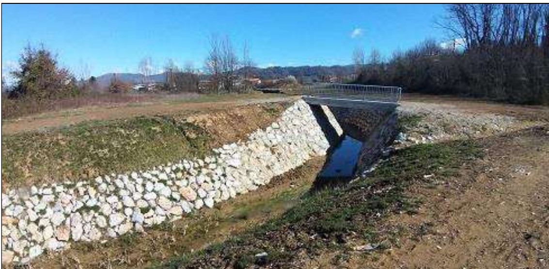
Fig. 11 Adeguamento del tombino in un ponte in cemento armato
