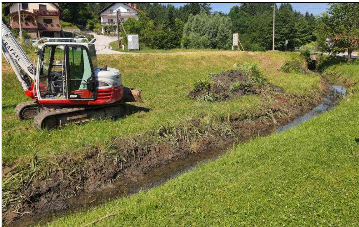
Figura 10: Alveo del fiume prima dei lavori
