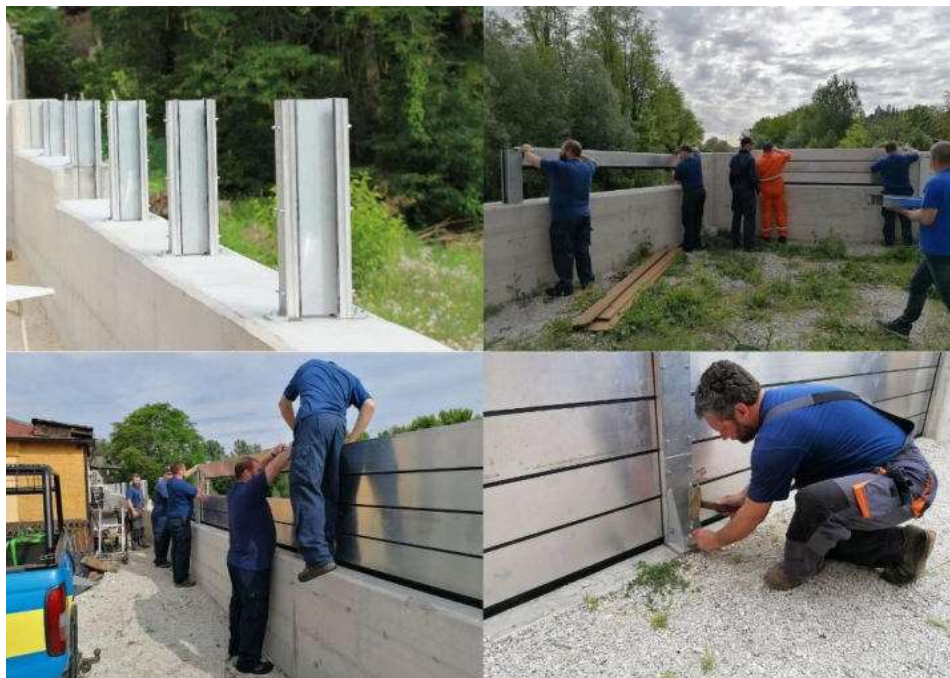
Slika. 12. Montaža mobilne stene
