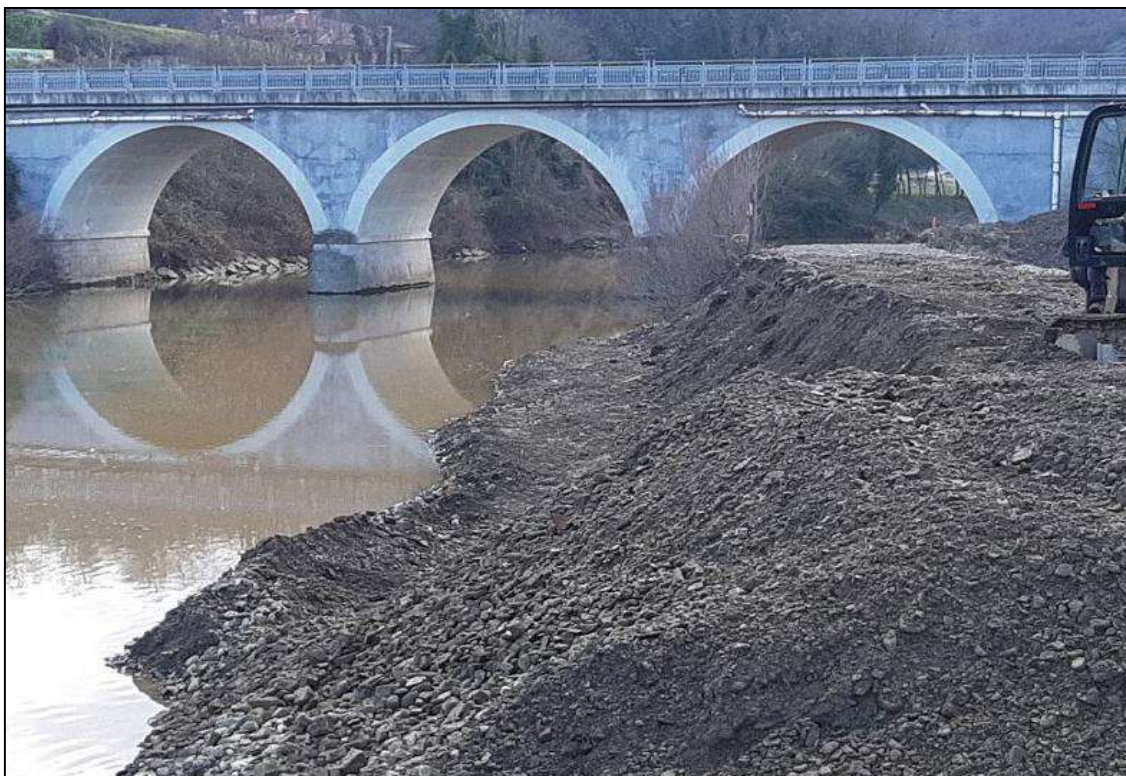
Fig. 7 Fase di realizzazione dell'intervento pianificato per proteggere l'insediamento di Draga dalle inondazioni
