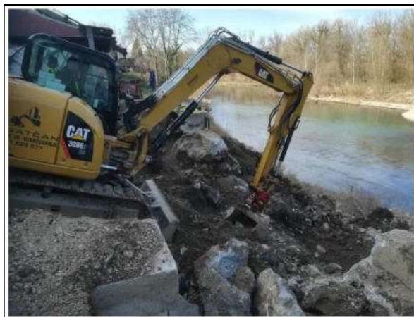
Fig. 8 Fasi costruttive del muro di protezione
