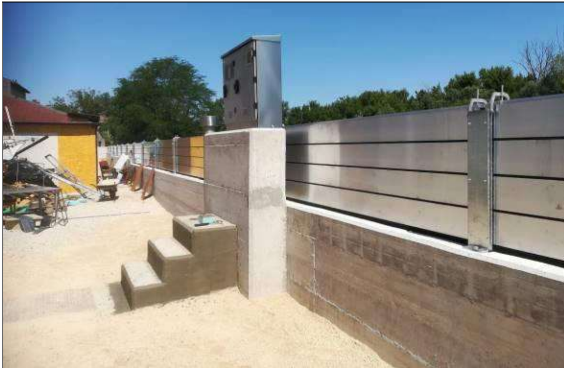
Fig. 10 Installazione dell'impianto elettrico
