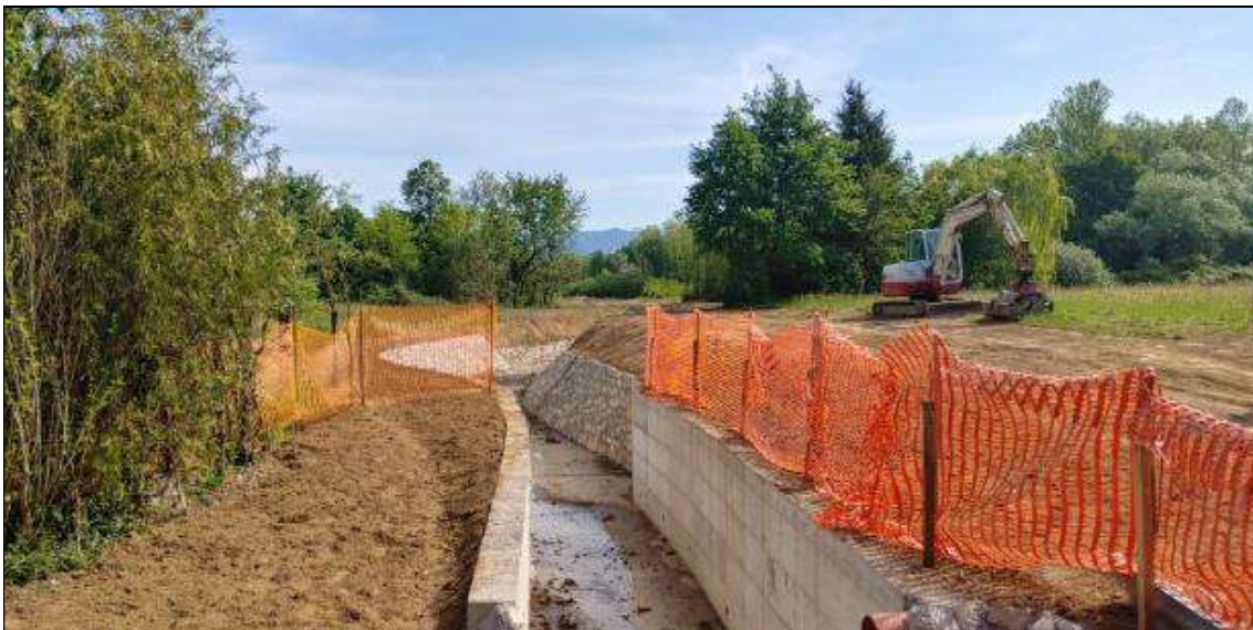
Slika 10 Konstrukcija betonskega kanala v obliki črke U
