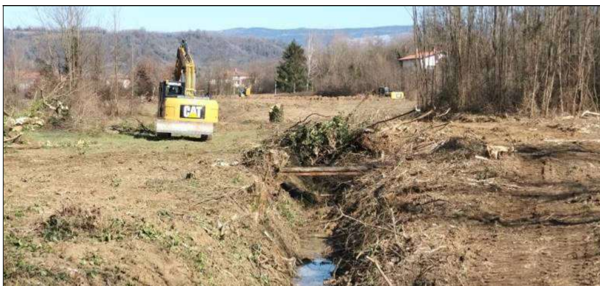
Fig. 8 Preparazione e pulizia dell'area di cantiere
