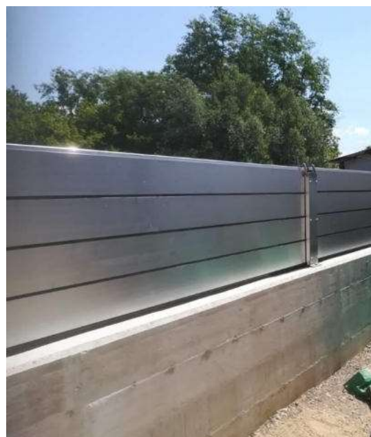
Fig. 12. Installazione delle paratoie mobili
