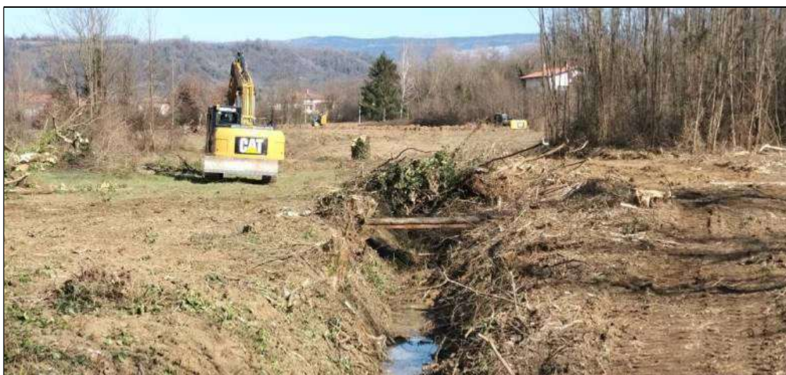
Slika 8 Gradbena dela: priprava in čiščenje tal
