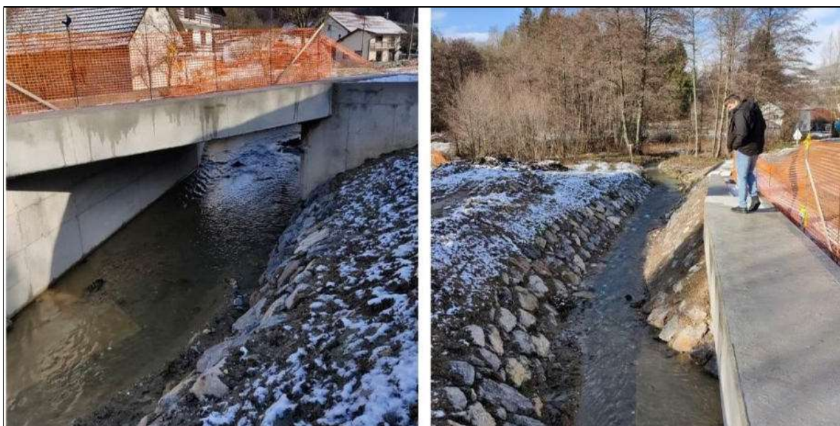
Figura 11: Lavori prima della conclusione
