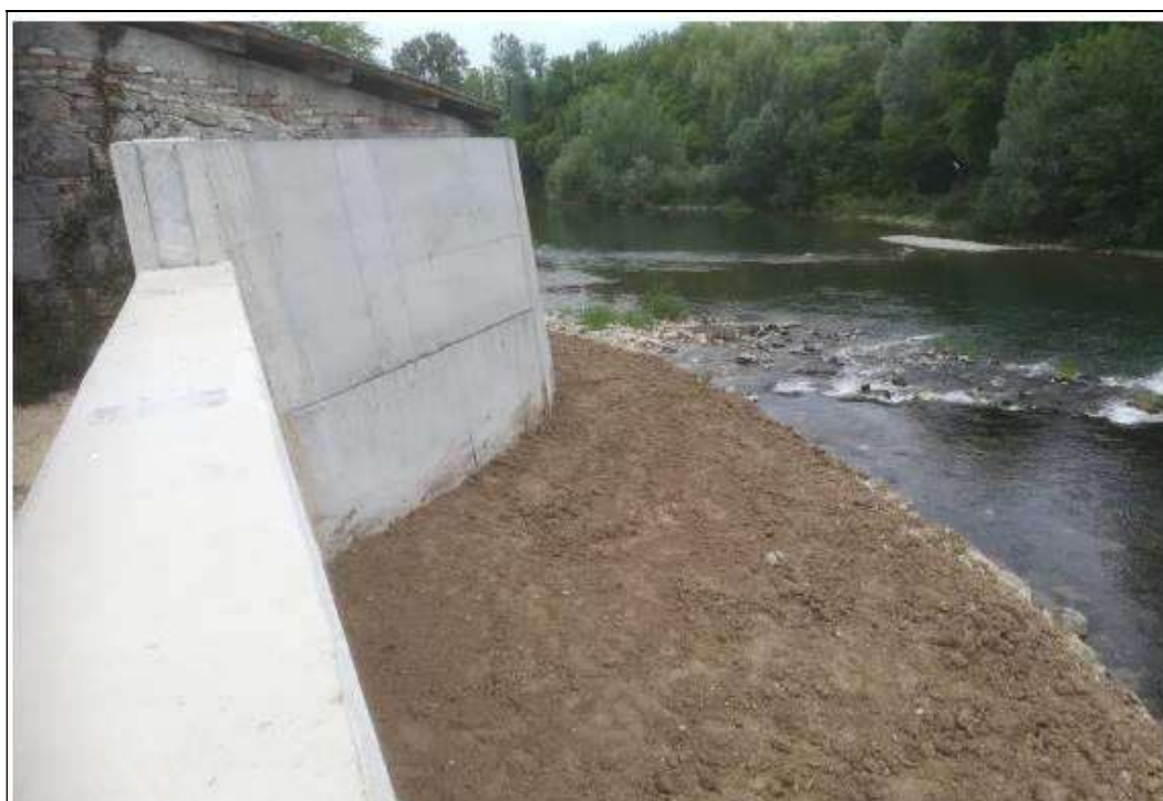
Fig. 9 Ulteriori immagini relative alla costruzione del muro di protezione
