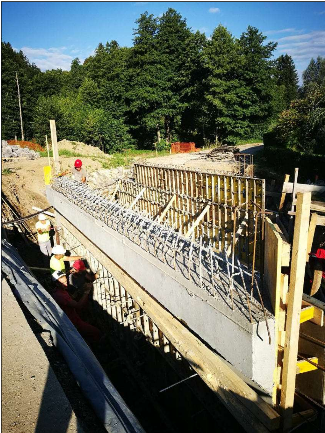
Figura 9: Costruzione del tombino idraulico n. 1
