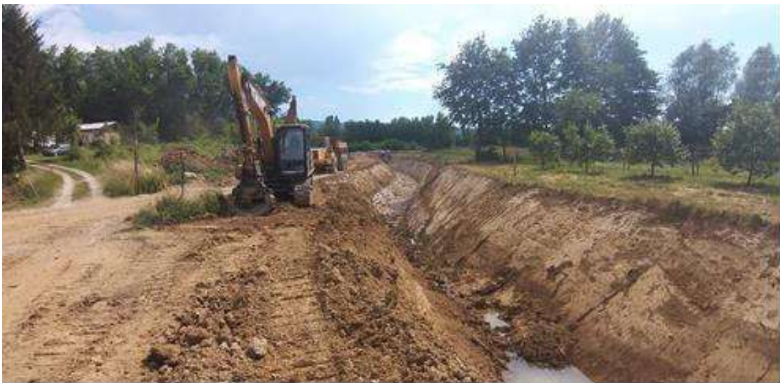
Fig. 9 Allargamento della sezione del corso d'acqua "J2"
