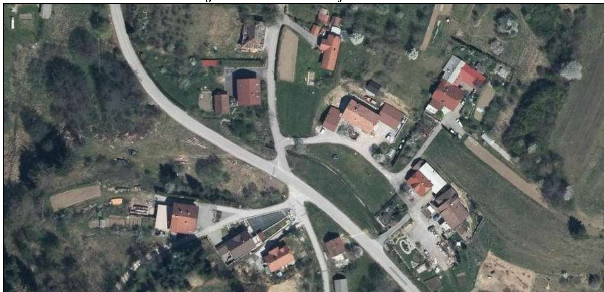
Figura 2: Area dei lavori sul fiume Belška voda
