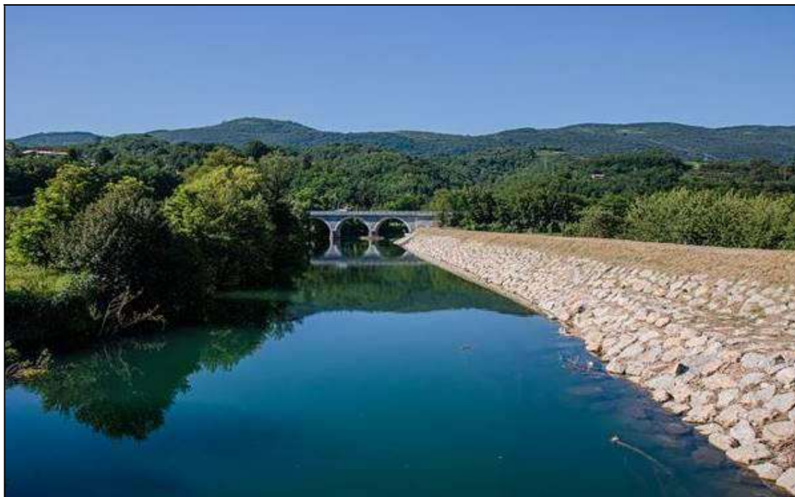
Fig. 9 Ulteriori immagini sui lavori ultimati
