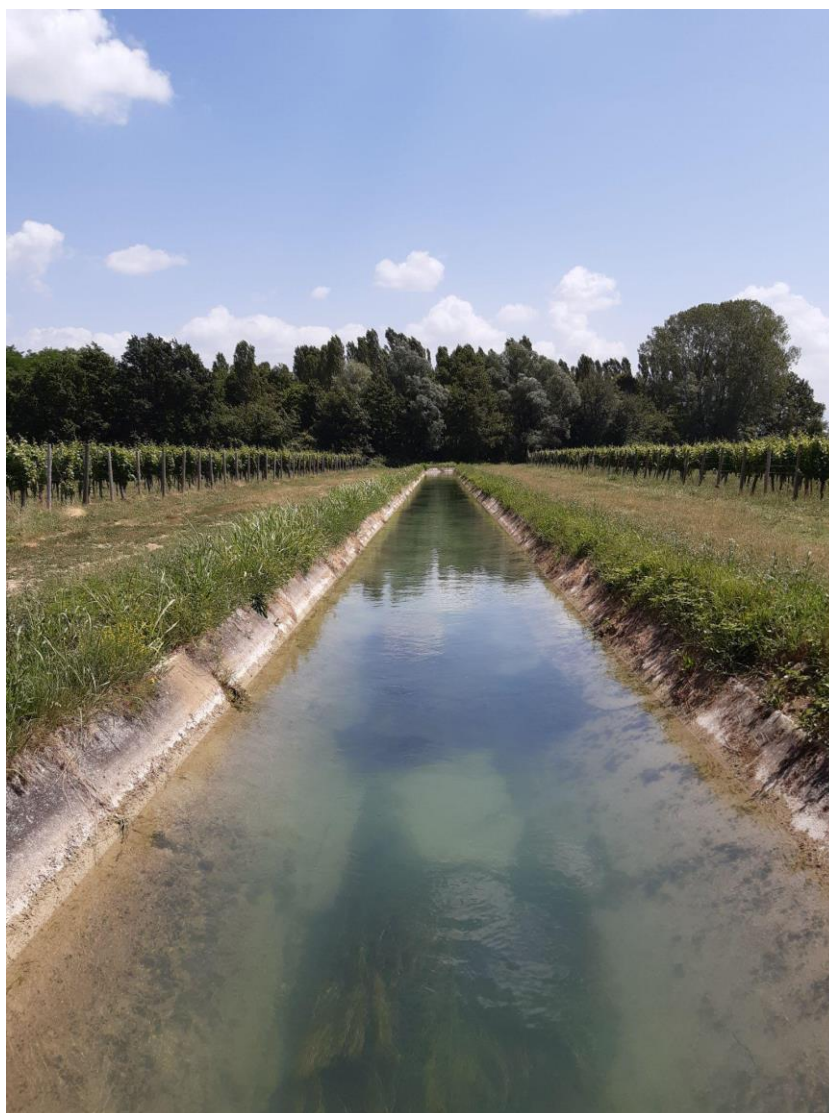
Slika 4 - Namakalni kanal konzorcija za melioracijo Venezia Giulia, ki prečka porečje Rio Bisinta. V kanaul teče voda iz struge bližnje reke Soče do kmetijskih površin v okolici Krmina.
