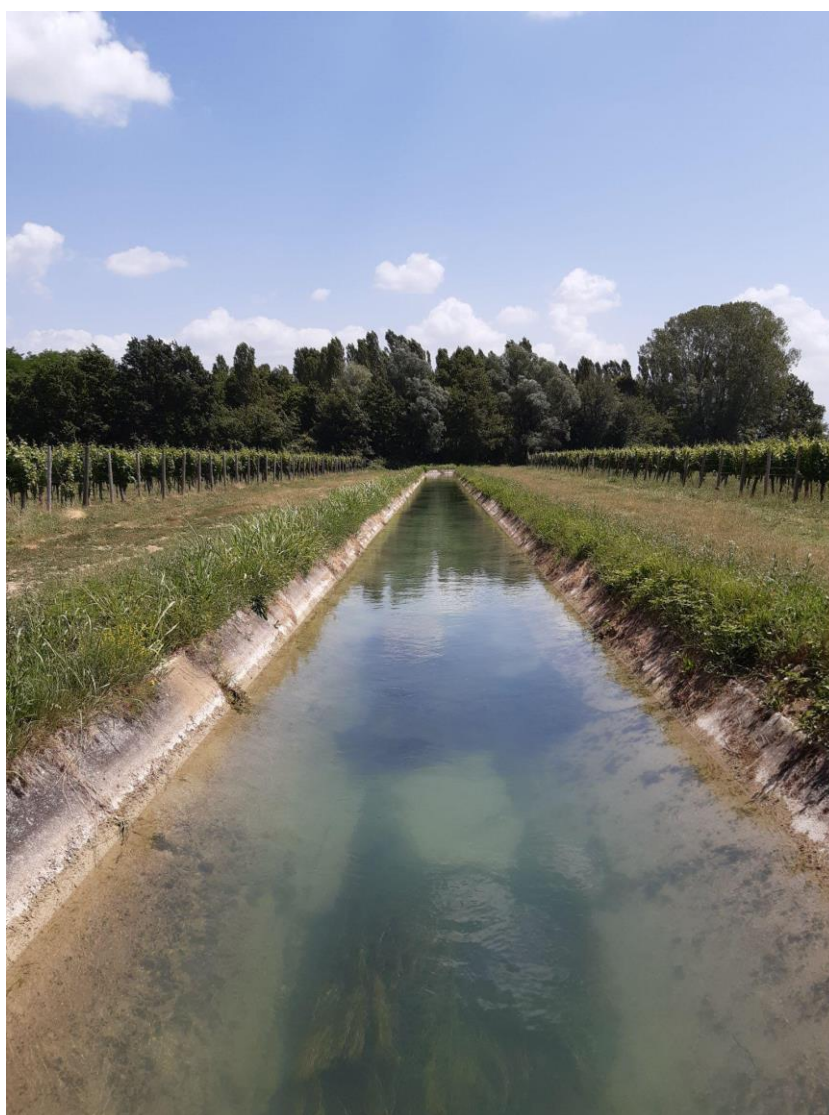
Figura 4 - Canale irriguo del Consorzio di Bonifica della Venezia Giulia che attraversa il bacino del rio Bisinta. Il canale trasporta l'acqua dall'asta del vicino Isonzo alle zone agricole nei dintorni di Cormons.
