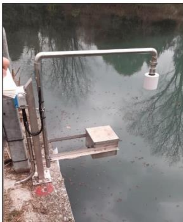
Figura 7. Fasi del rilievo.
