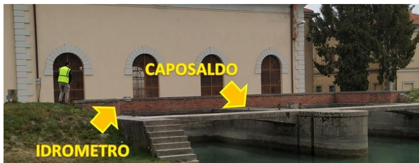
Figura 9 – Opera con idrometro e caposaldo
