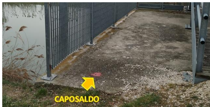
Figura 8 – Caposaldo sul fianco dell'opera
