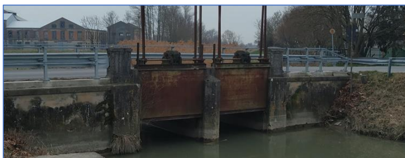
Figura 5 – Ponte con chiviche
