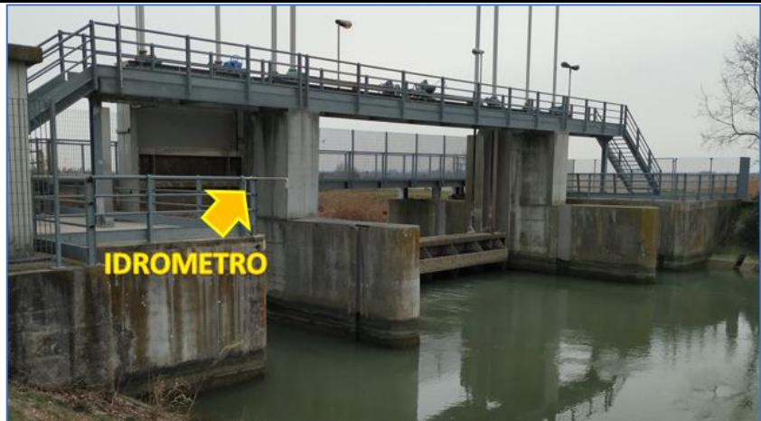
Figura 7 – Opera con idrometro
