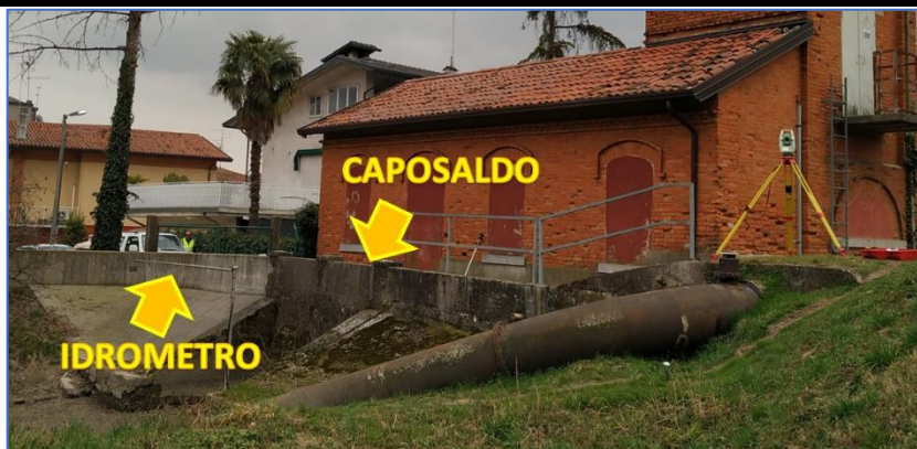
Figura 19 – Opera con caposaldo e idrometro
