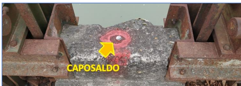
Figura 6 – Nuovo caposaldo da livellazione IGM
