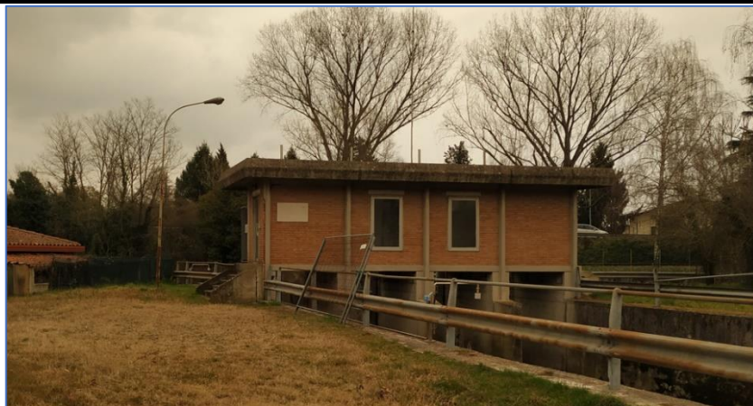
Figura 20 – Opera deviatore vista da valle
