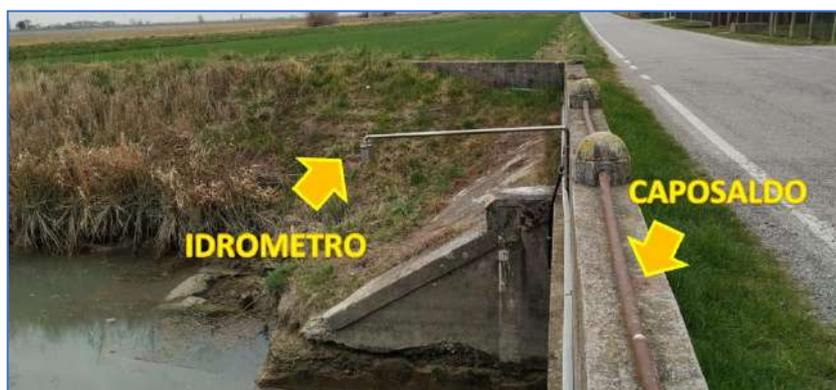
Figura 14 – Posizione caposaldo ed idrometro
