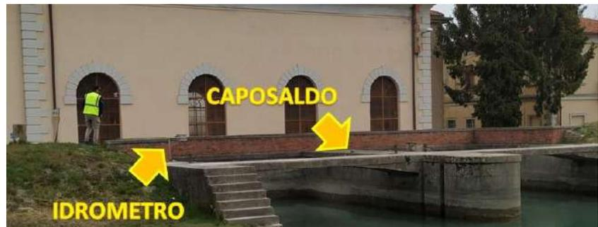
Figura 9 – Opera con idrometro e caposaldo
