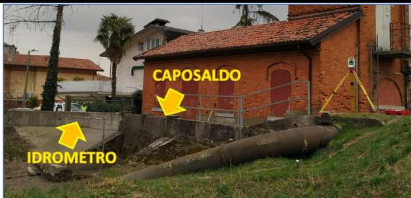
Figura 19 – Opera con caposaldo e idrometro
