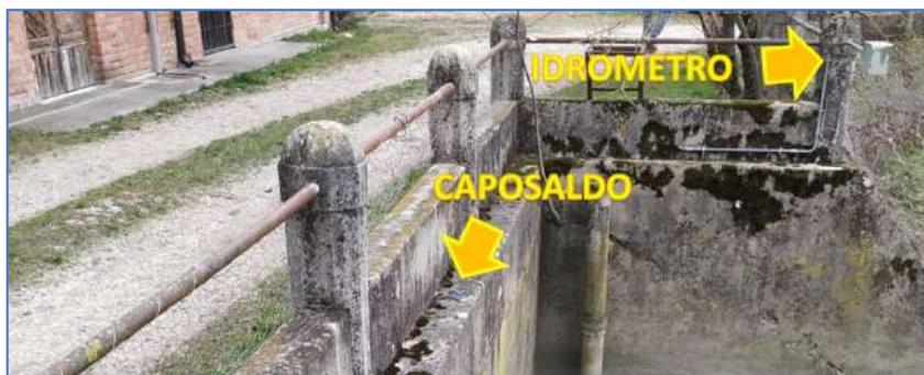
Figura 18 – Posizione idrometro e caposaldo
