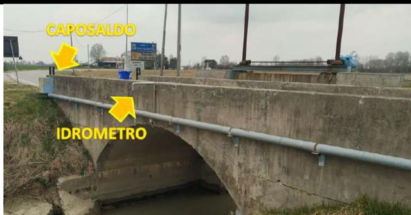
Figura 15 – Posizionamento idrometro e CS su ponte
