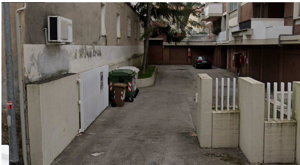
Fig. 10 – Esempio di contenitori pluri-utenza posizionati in area privata condominiale – Via Marzio Moro
