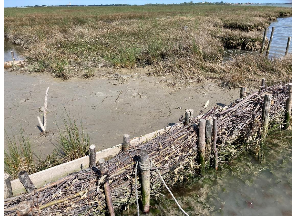
Fascinata con legno da potature e refluentamento Obramba narejena z lesom, ki prihaja iz obrezovanja in pretoka
