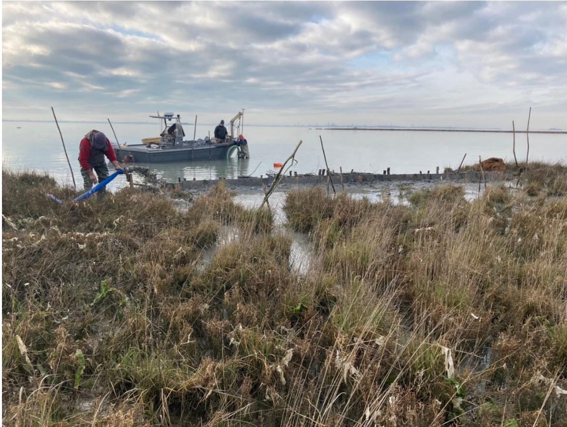
Operazioni di refluentamento con sedimenti da velma adiacente Posegi za ponovni pretok s sedimenti iz sosednjega muljastega predela
