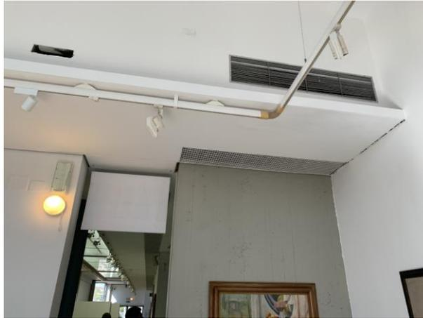
Figura 5: Particolare delle bocchette di immissione e delle griglie di estrazione nell'area espositiva.
