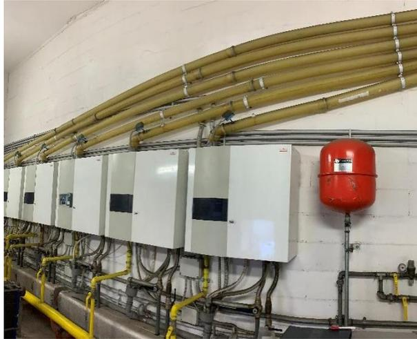
Figura 3 caldaie per la produzione dell'acqua calda.
