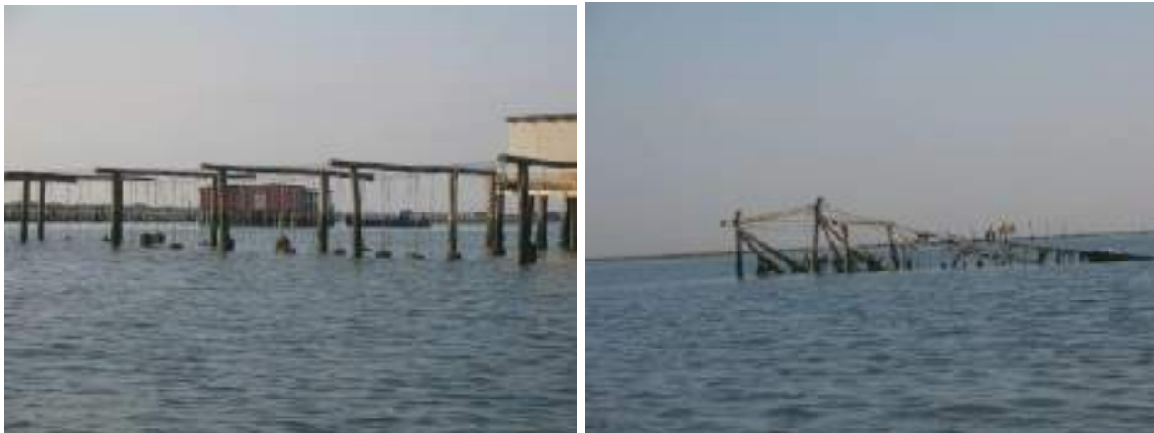
Slika 35: Strukture ribogojnic za gojenje školjk in njihova degradacija.
