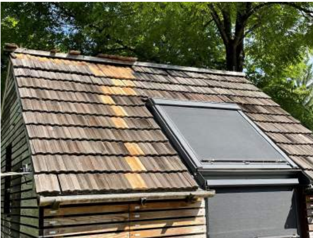
Slika 18: Streha, iz katere so bili izolirani strešniki po 8 letih uporabe
