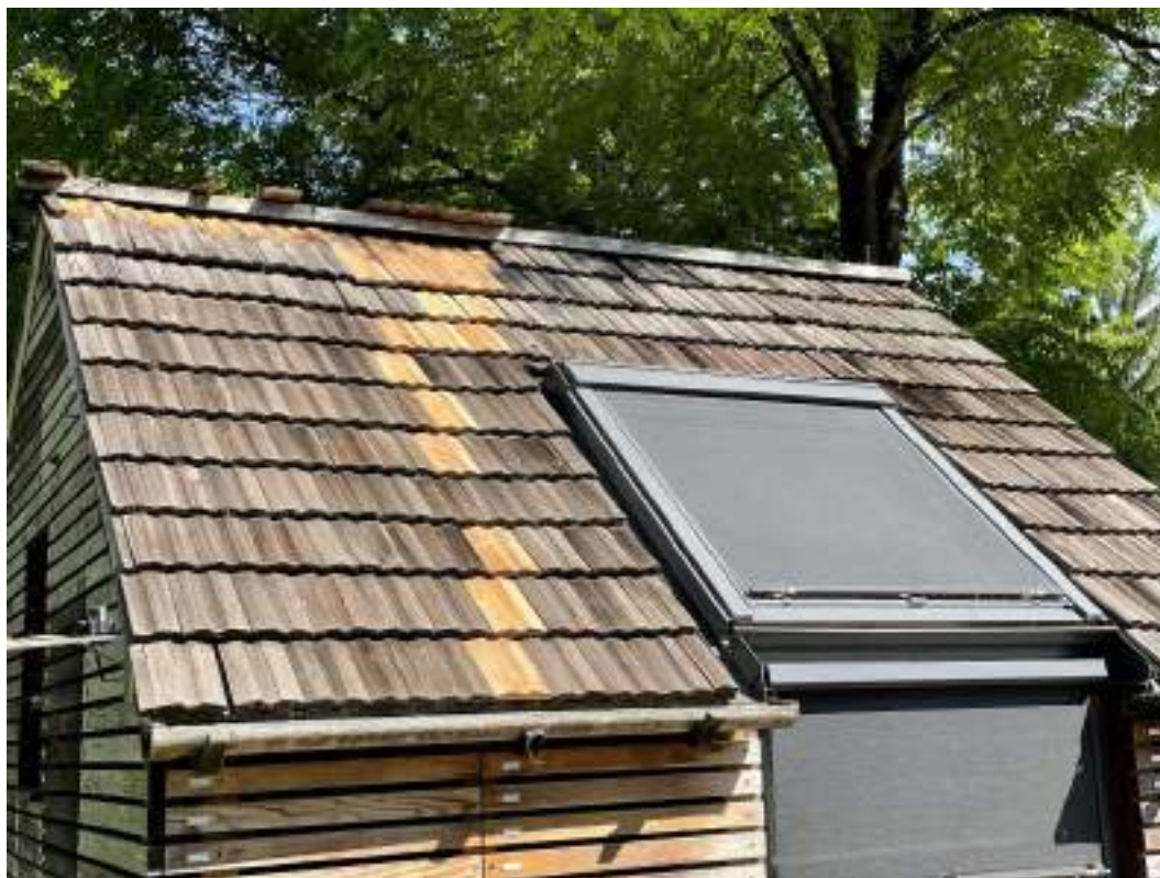
Immagine 18: Tetto dal quale sono state prelevate le scandole dopo 8 anni di utilizzo.
