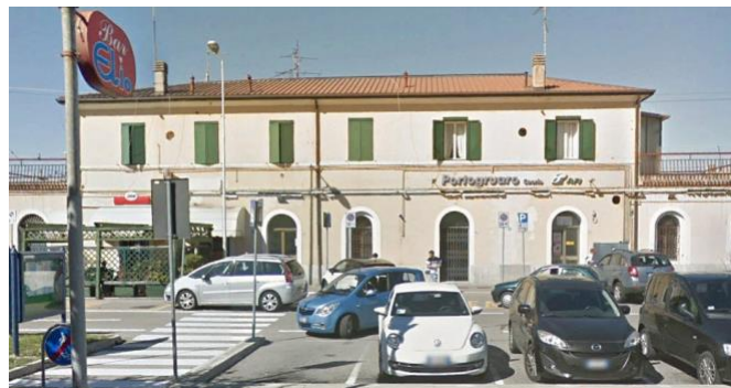
Figura 2 stazione FS di Portogruaro
