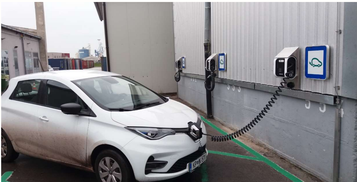
Slika 1: stenske polnilnice za električna vozila postavljene na Terminalu za Avtomobile
