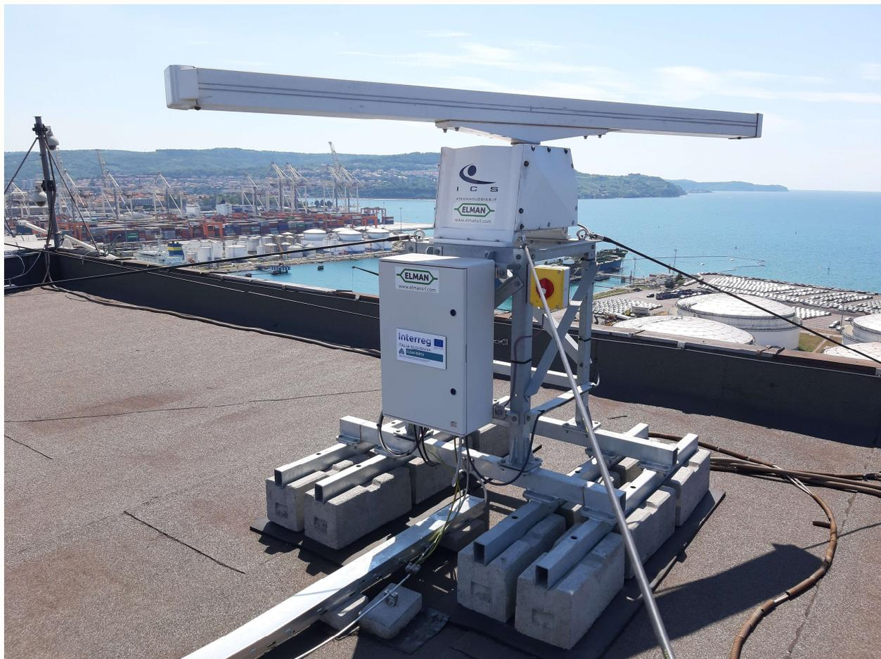
**Figura 3:** il nuovo sistema radar per il rilevamento di tracce di idrocarburi sulla superficie di mare in funzione
