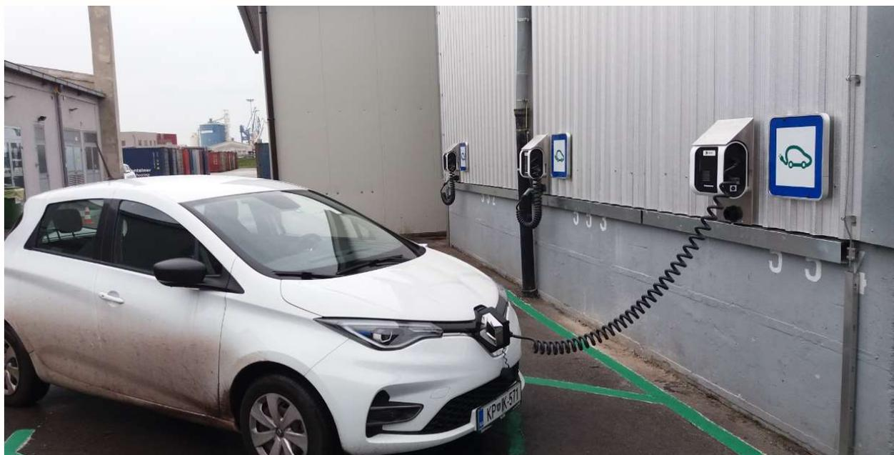
Figura 1: stazioni di ricarica per veicoli elettrici, installate presso il terminal auto
