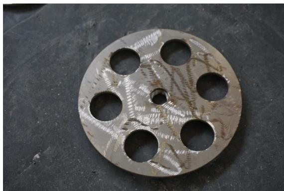
Slika 2: Sidrna glava povezovalnih sider premera 150 mm (levo) in montaža sidra (desno).
