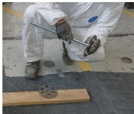
Slika 2: Sidrna glava povezovalnih sider premera 150 mm (levo) in montaža sidra (desno).
