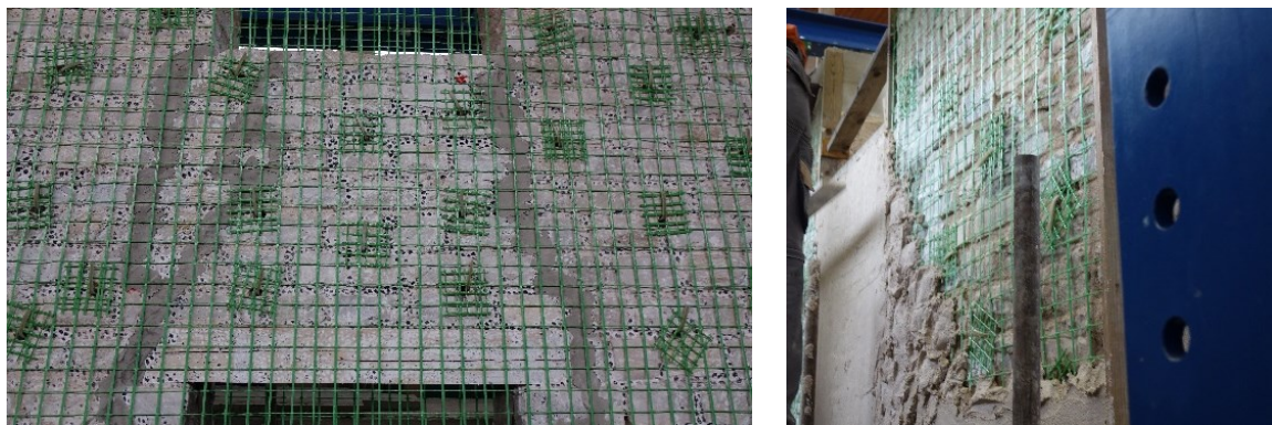
Slika 9: Nameščanje mreže (levo) in nanašanje obloge z ometavanjem (desno).
