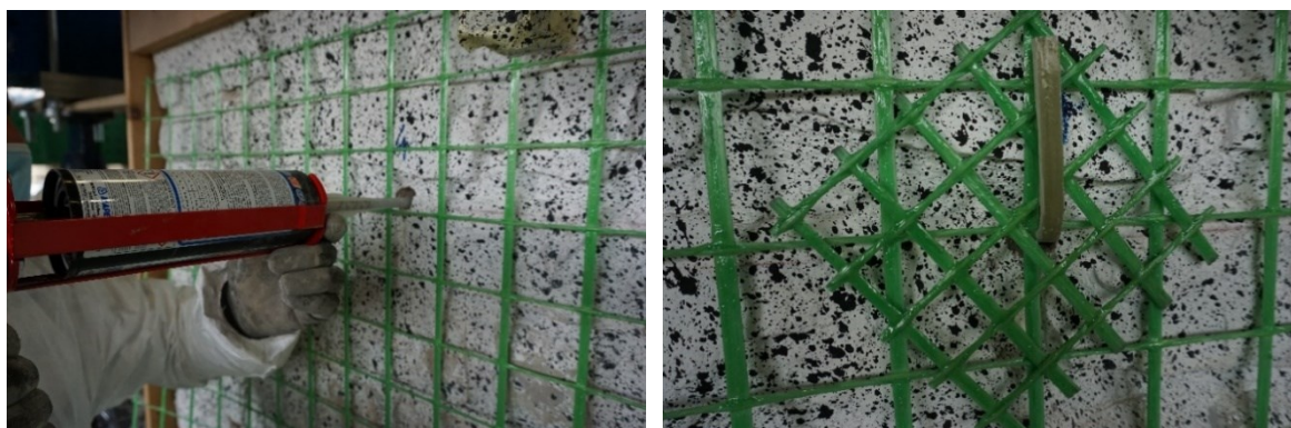
Slika 7: Montiranje L sider (levo) in podložna mrežica (desno).
