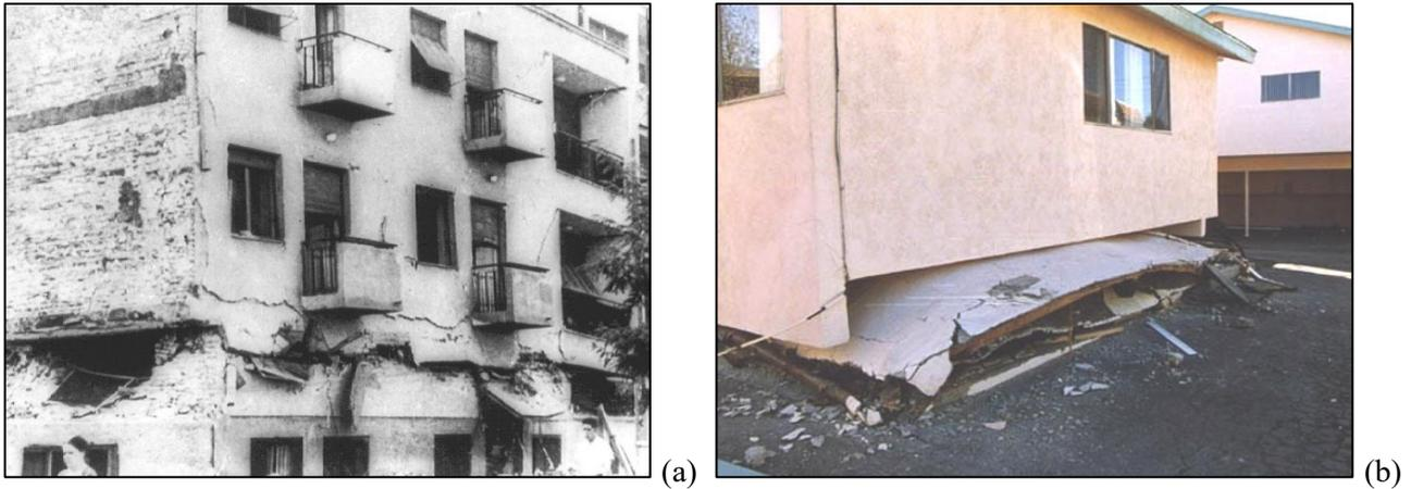
Fig. 11: Failure of soft storey: a) (Skopje, 1963), b) (Neftegork, 1994)<sup>3</sup>.
