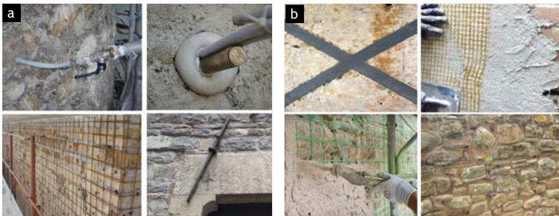
Fig. 3 Interventi per il miglioramento delle prestazioni della muratura esistente: alcune tecniche tradizionali (a) e moderne (b).
