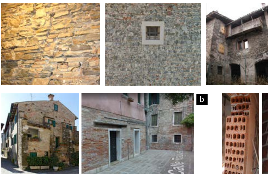
Fig. 2 Tipologie murarie ricorrenti nell'area del Programma: pietra (a) mattoni pieni (b) e mattoni forati (c).
