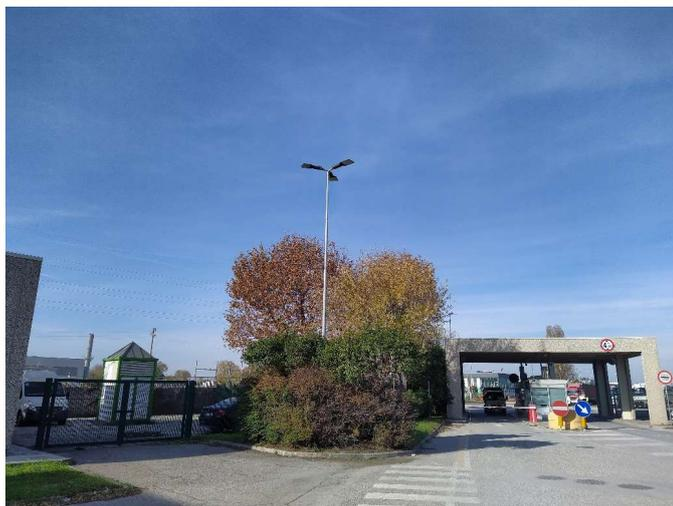
Figura 6: Punti luce sui pali ingresso porto con lampade LED della potenza da 97 a 146 W (COSEF)
