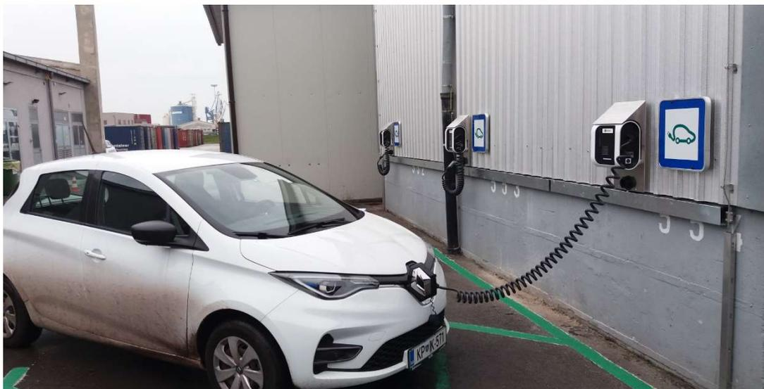
Figura 3: Stazioni di ricarica per veicoli elettrici, installate presso il terminal auto
