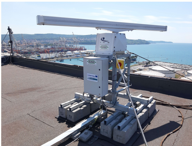
Slika 13: Nov radarski sistem za zaznavanje ogljikovodikov na morski gladini (Luka Koper)
