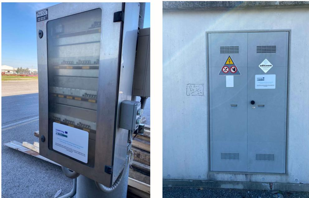
Slika 10: Namestitev električnih nadzornih omaric za razsvetljavo (COSEF)
