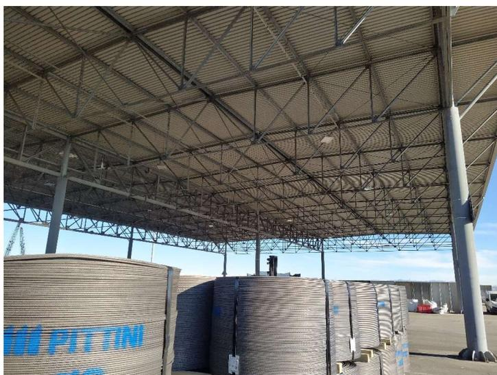
Figura 9: Punti luce sospesi presso le tettoie di ricovero materiali sud e nord con lampade LED della potenza di 230 W (COSEF)
