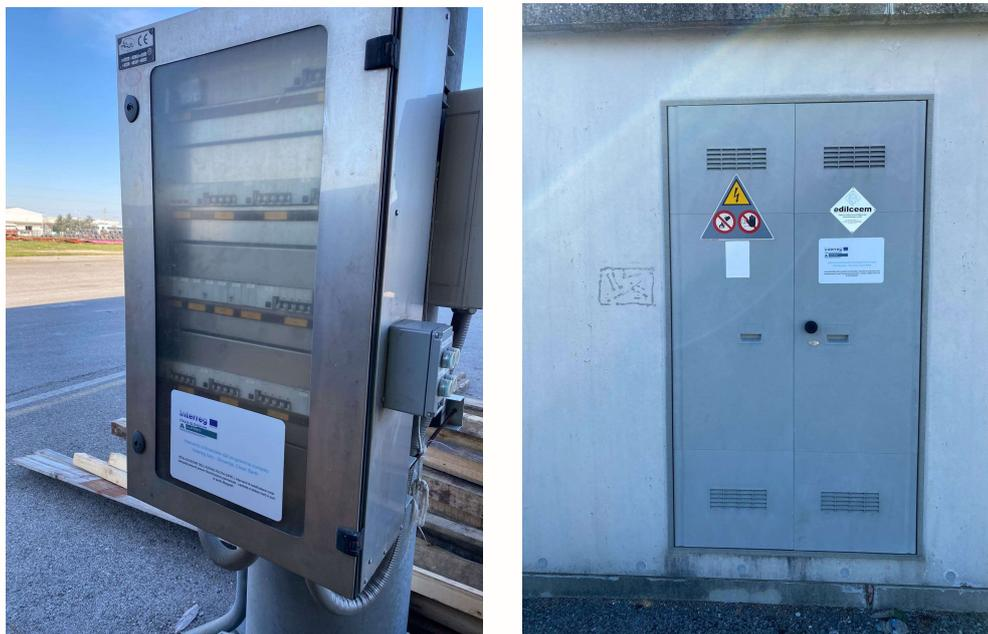
Figura 10: Installazione dei quadri elettrici di comando degli impianti di illuminazione (COSEF)
