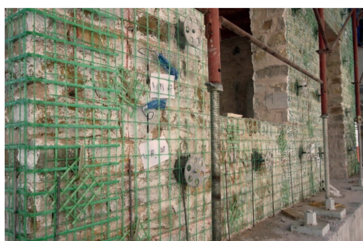
Skica predlagane tehnike utrjevanja (od leve proti desni): neutrjen, enostransko in dvostransko utrjen zid, primer iz prakse in načrt utrditve ter sidranja v temelj.
