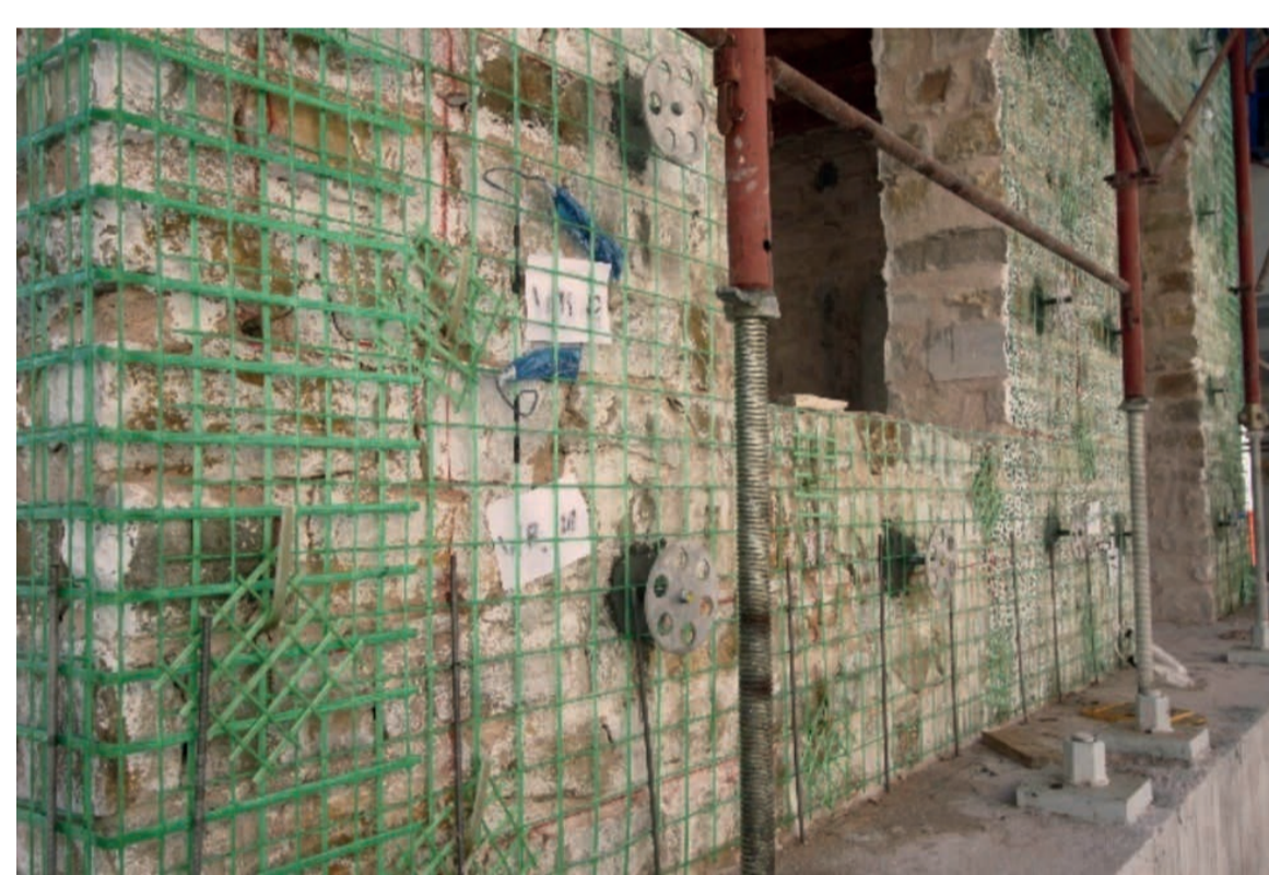
Dettagli della tecnica di rinforzo proposta (da sinistra a destra): confronto tra muratura non rinforzata, rinforzata su un solo lato e rinforzata da entrambi i lati; esempio di applicazione; collegamento in fondazione.
