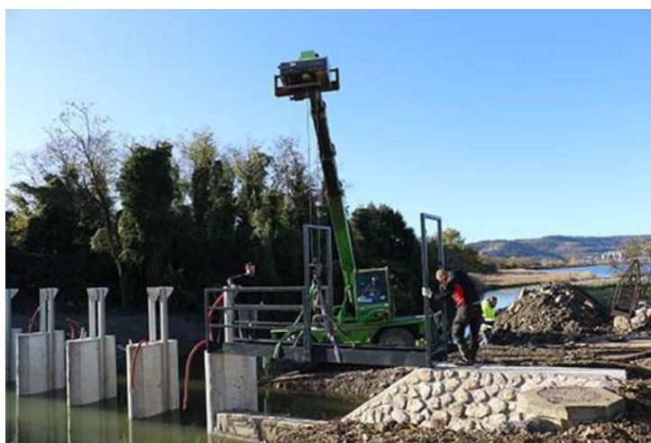
Slika 2: Sanacija vodnega praga na Ari ter ureditev avtomatskega zaporničnega sistema (levo) in nadgradnja zapornice na morskem kanalu (desno). Vir: (Mozetič in sod., 2021)
