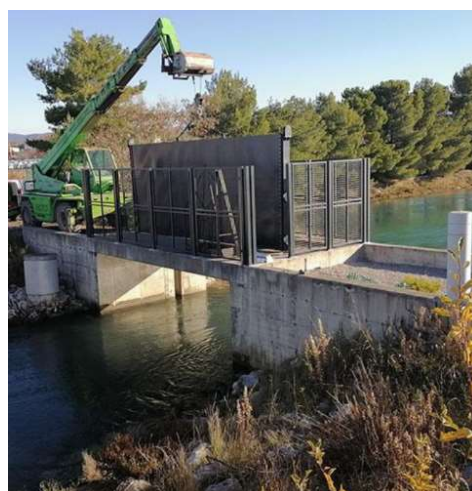
Slika 2: Sanacija vodnega praga na Ari ter ureditev avtomatskega zaporničnega sistema (levo) in nadgradnja zapornice na morskem kanalu (desno). Vir: (Mozetič in sod., 2021)
