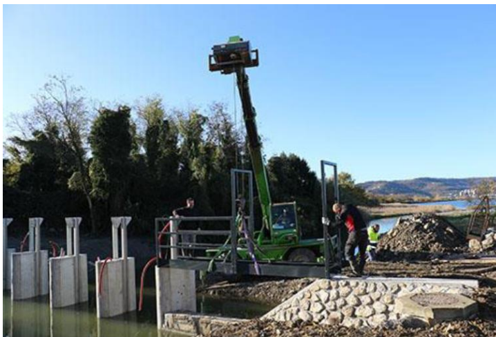
Figura 2: Riabilitazione della soglia d'acqua sull'Ara e assetto del sistema di sbarramento automatico (a sinistra) e potenziamento dello sbarramento sul canale marittimo). Fonte: (Mozetič et al., 2021)
