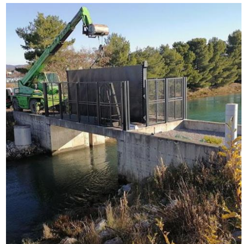
Figura 2: Riabilitazione della soglia d'acqua sull'Ara e assetto del sistema di sbarramento automatico (a sinistra) e potenziamento dello sbarramento sul canale marittimo). Fonte: (Mozetič et al., 2021)
