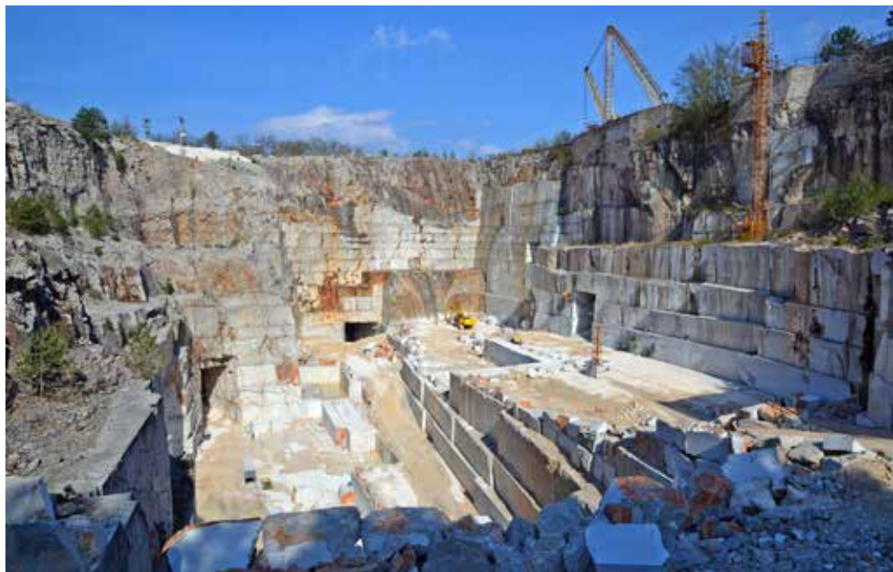
Figura 4.2.11: La cava Lipica 1 si trova a nord-est della nota scuderia di Lipica. In questa cava vengono estratti grandi blocchi di calcare massiccio del Cretacico. (Foto: Matevž Novak)
