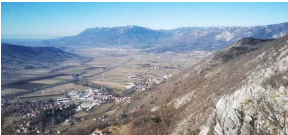
Figura 2.4.4: La valle del Vipava separa il Carso dagli altopiani carsici di Trnovski Gozd e Nanos (in alto e a destra) (Foto: Bojan Otoničar)
