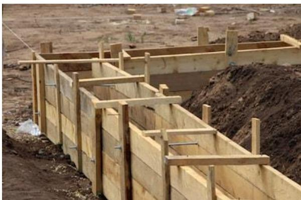
Figura 3: cassaforma in legno ([www.construire.it](http://www.construire.it))
